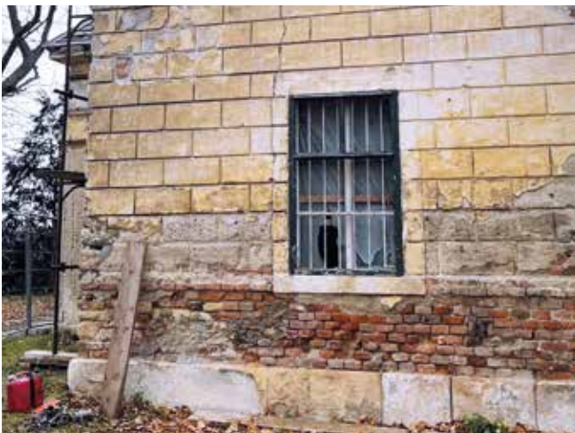
Zugemauerte Portaltür zu einem Fenster – die Vergitterung fehlt (Foto oben). Zum Vergleich Seitenfenster mit Originalgitter (Foto unten).
