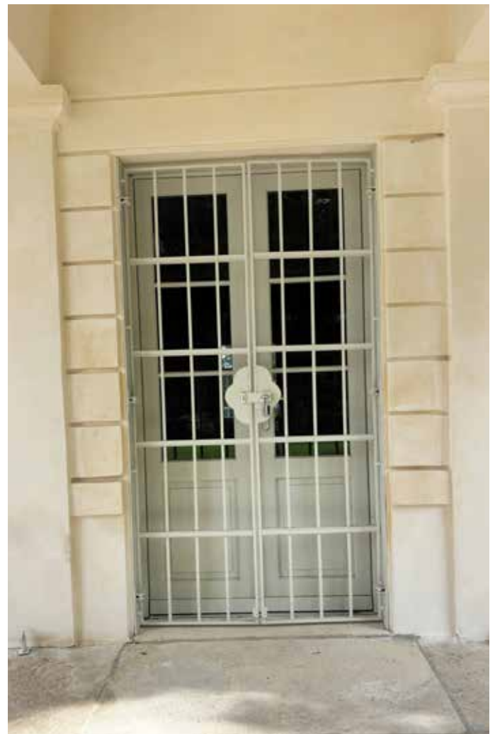
Der Haupteingang inkl. Vergitterung – im alten Design – wurde wieder hergestellt. Jetzt ist das Wächterhaus komplett.
