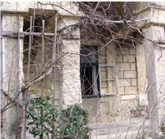
Zugemauerte Portaltür zu einem Fenster – die Vergitterung fehlt (Foto oben). Zum Vergleich Seitenfenster mit Originalgitter (Foto unten).
