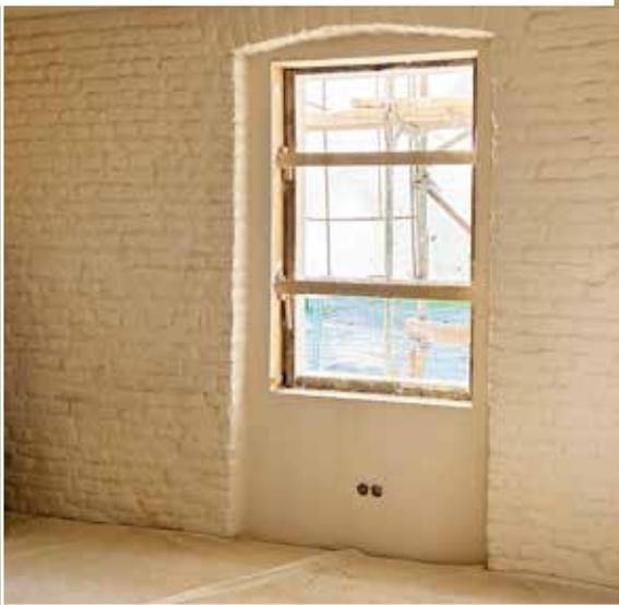
In den letzten Wochen ging es beim Innenausbau des Wächterhauses im Schlosspark Pottendorf weiter voran. So wurde der Trockenausbau im Innenbereich: abgehängte Gipskartondecke und Vorsatzschalen an den Wänden im Küchenbereich montiert. Auch die Fußbodendämmung ist fertiggestellt und der eingebrachte Estrich bereits ausgetrocknet.
