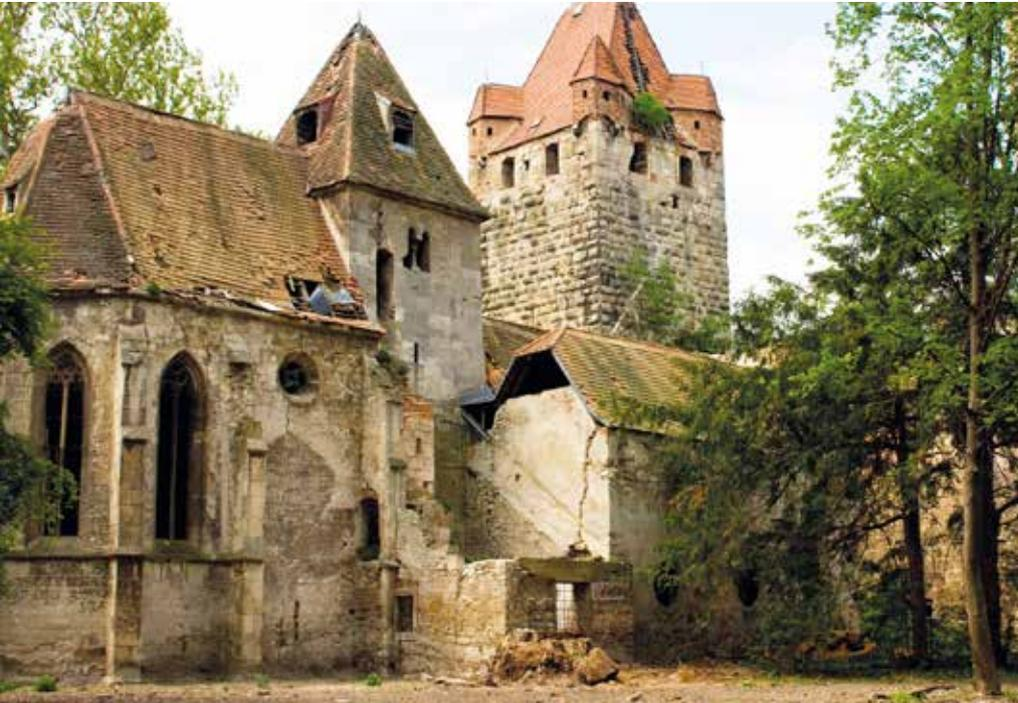
Auch auf der Rückseite der Schlosskapelle sind die Sanierung der Sakristei, die gesicherte Fassade und das neue Dach gut zu erkennen.
