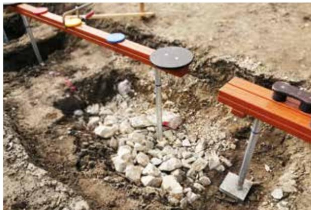
Die Planung des Außenbereichs wurde unter der Leitung von Albert Komposch der Firma AGROPAC, die auch die Geräte gefertigt haben, durchgeführt. Ab dem 27. Februar startete der Aufbau. Im ersten Schritt setzten Bauhofmitarbeiter die Markierungen für die Gerätestandorte. Mit einem Bagger konnten im zweiten Schritt die Fundamente und Vertiefungen
